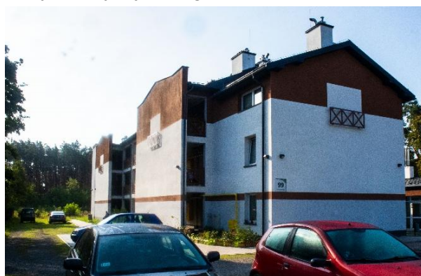
Komunalny budynek wielorodzinny przy ul. Wyszyńskiego 99
